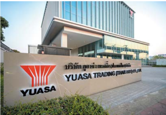
「LEED GOLD」認証を取得した、タイ現地法人「YUASA (THAILAND) CO.,LTD.」の環境配慮型の新社屋 (YUASA提供)
