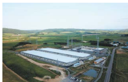
蓄電池設備外観
