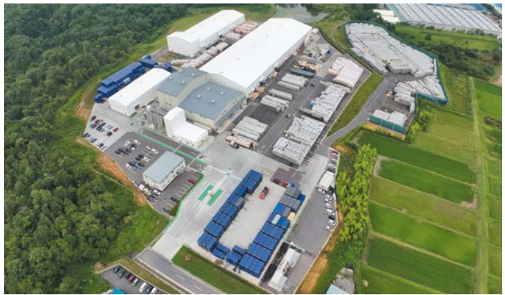
豊通ペットリサイクルシステムズ(株)全景 (豊田通商 提供)
