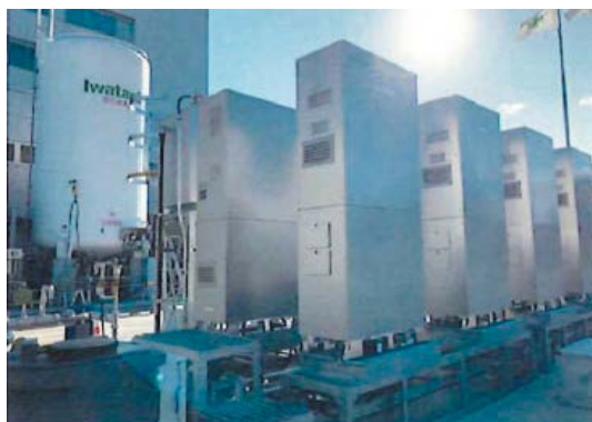
中央研究所に導入した純水素型燃料電池（岩谷産業 提供）
