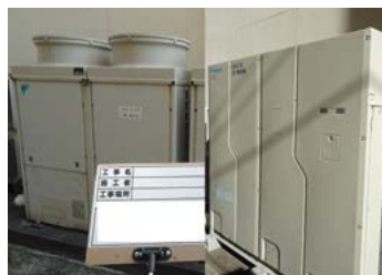
高効率空調機への更新（補助率約3割：「先進的省エネルギー投資促進支援事業費補助金」（経済産業省））（ユアサ商事提供）
