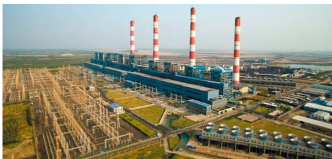
アダニパワームンドラ石炭火力発電所
