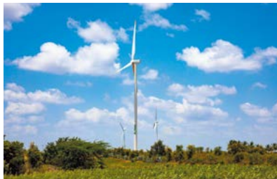
ReNew 社保有 Karnataka 州 SECI VI Wind power project 116MW
