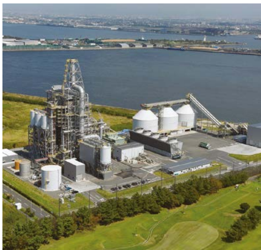
サミット半田パワー 発電所全景
