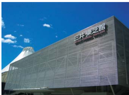
三井・東芝館 幅150mの壁を水が伝わるアクアウォール
