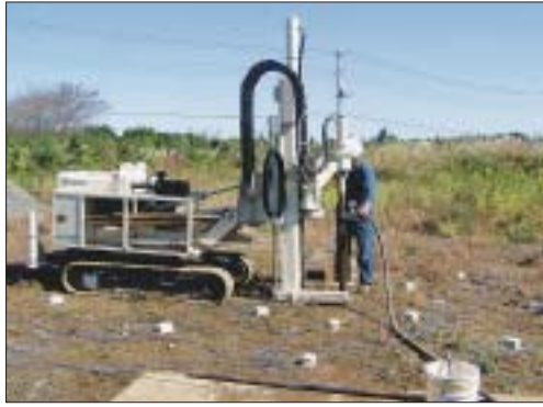
土壌浄化作業 直径5cmの井戸を掘り、浄化剤を注入する
