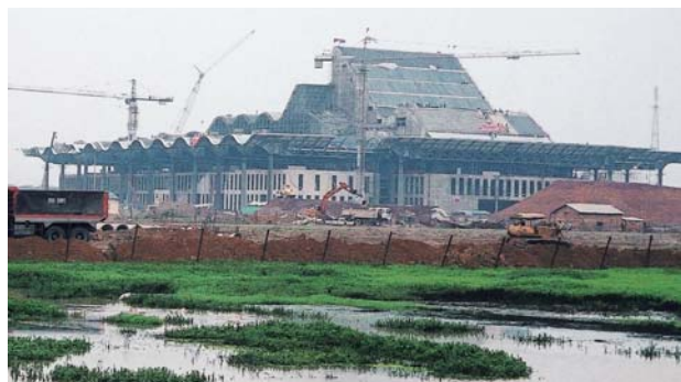
11月下旬のAPEC会議に向けて建設中の国際会議場 (ハノイ市西部コーザイ地区)
