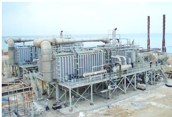
紅海岸クンファダで建設中の多重効用型海水淡水化プラント
