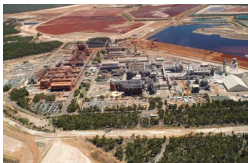
ワースレーアルミナプロジェクト (西豪州) 年産310万トン。世界最大級のアルミナ工場。1984年稼働開始(双日提供)
