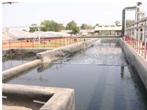
キャッサバ・ウエスト・ツー・エナジー社 排水リサイクルシステム (手前) およびメタン回収発酵槽 (左奥のテント)
