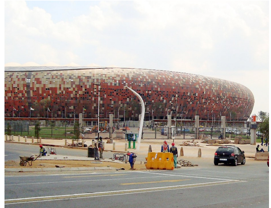
急ピッチで工事が進められる Soccer City
