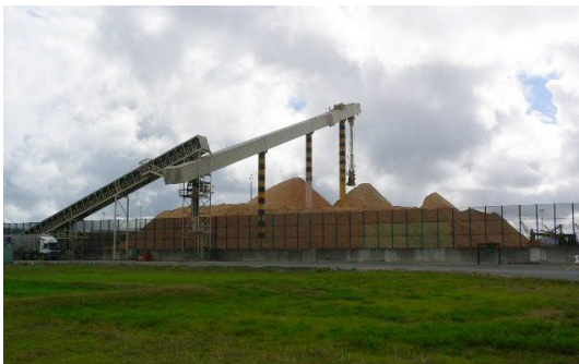
MWCチップヤード（Marsden Point港）
