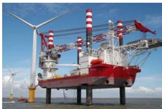
丸紅が保有する英国ガンフリート・サンズ洋上風力発電所にてメンテナンス作業中のSeajacks Zaratan号
