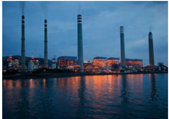
Paiton発電所全景
