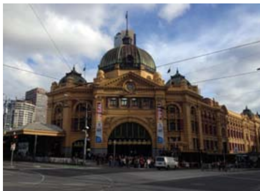
1854年完成時の姿を残すメルボルンの象徴的建造物で豪州最初の鉄道駅、フリンダースステーション
