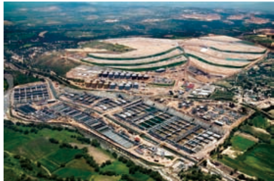
世界最大の下水処理場（処理量：360 万 t / 日） Atotonilco の建設現場
