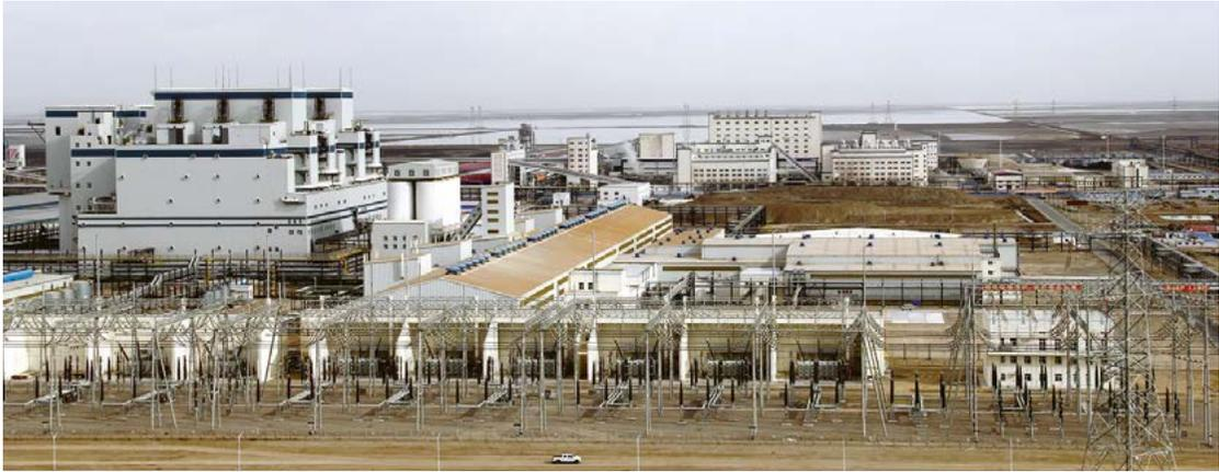
中国青海省で近々に操業を開始する将来的に世界最大規模の電解法によるマグネシウムの新工場です。フル稼働時には世界需要の約50%を生産可能な規模です。従来の熱還元法によるマグネシウム製造方法に比較し、製造時に発生する二酸化炭素が約4分の1、アルミに対しても2分の1と大幅な削減に寄与することが可能となります。当社は、この工場で製造されるマグネシウム地金の日本国内と海外進出されている日系企業様への代理店として活動します。
