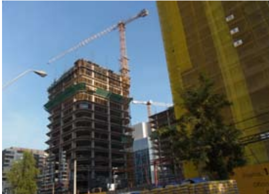
建設の進むサンティアゴ市内
