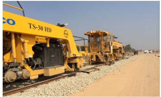
デポに搬入されている Track Stabilizer
