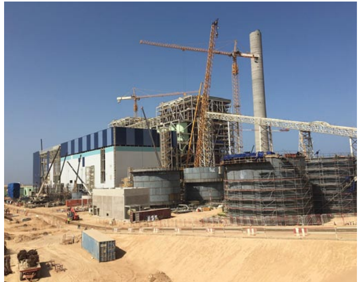
サフィ火力発電所（建設中）
