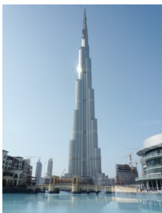
建設中のブルジュ・ドバイ（世界一の高層ビル）
