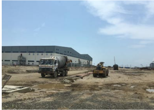
建設中のアダニソーラーパネル工場
