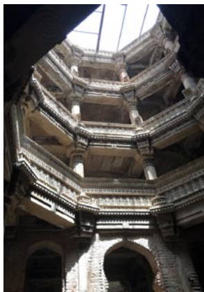
階段井戸内部
