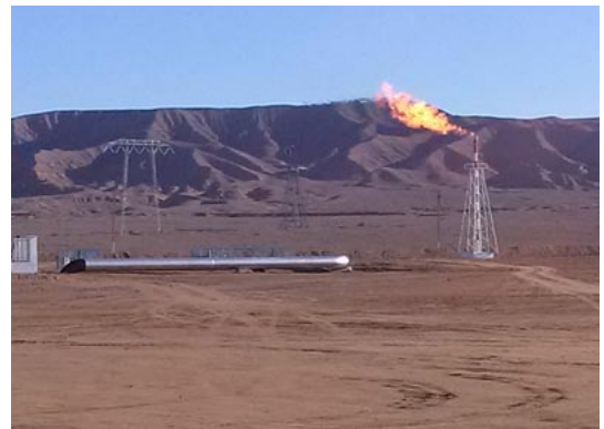
東西ガスパイプライン：東のガス田地帯と西のカスピ海を結ぶ773kmのガスパイプライン。2015年12月完成、30BCM／年移送可
