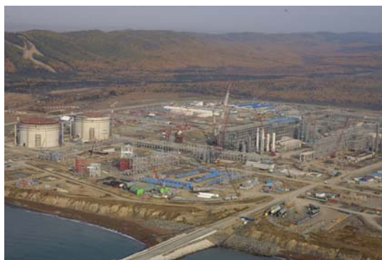
サハリン2LNG工場建設現場(サハリン・ブリゴドノエ)
