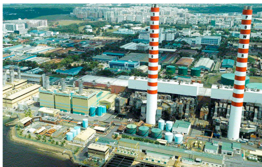
シンガポール北部にあるセノコ・パワー発電所
