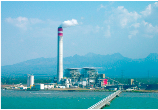
ジャワ島中部にあるタンジュンジャティB石炭火力発電所
