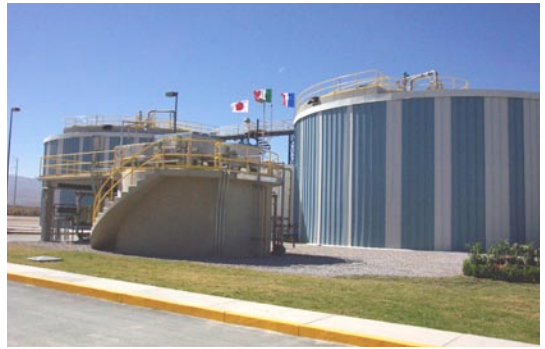
サン・ルイス・ポトシ市で運営中の下水処理場（右は汚泥消化タンク）
