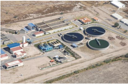
サン・ルイス・ポトシ市で運営中の下水処理場（右は汚泥消化タンク）
