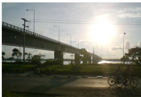
2006年12月に日本のODAで開通した 第2メコン国際橋 (2008年9月)
