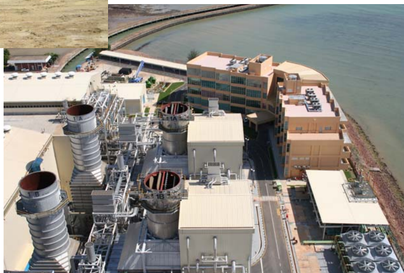
ポートディクソン火力発電所
