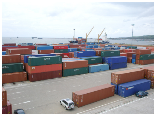
シアヌークビル港—カンボジア唯一の深海港で日本の援助でリハビリを実施。隣接地に経済特区を建設中
