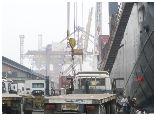
タンジュンプリオク港—インドネシア最大の貿易港。日本の援助で周辺の幹線道路整備を実施
