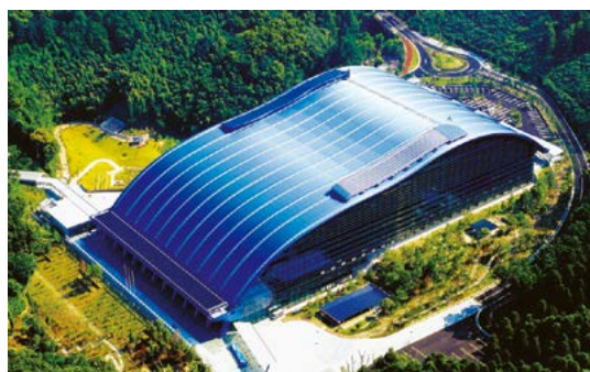
トランティクシーを用いた長尺屋根の施工例
