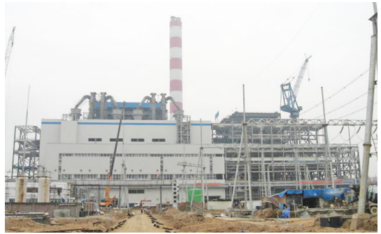
建築中のベトナム・ハイフォン石炭火力発電所
