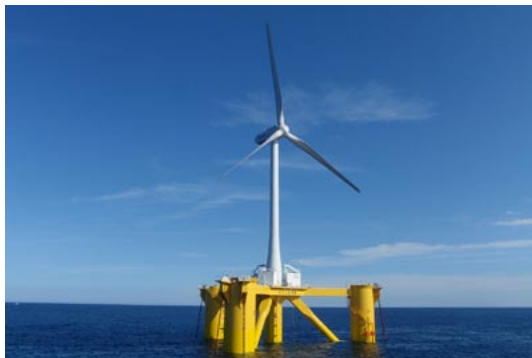
丸紅・福島洋上風力発電設備 (写真提供：福島洋上風力コンソーシアム)
