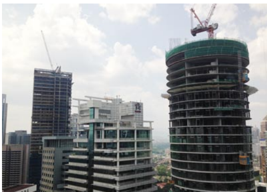
オフィス（29階）から見た建設中のビル群
