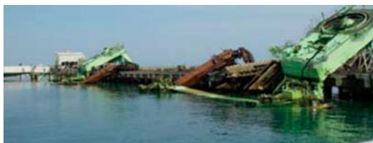
被災した火力発電所の状況
