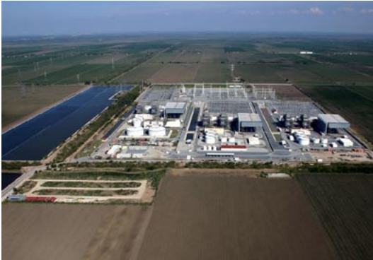
Rio Bravo天然ガスだき コンバインドサイクル（複合火力）発電所
