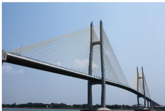
ネアックルン橋（つばさ橋）
